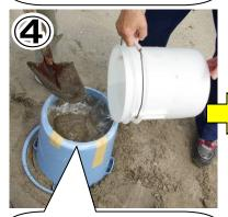
海水があるうちに、スコップでかき混ぜて、空気 を抜きます。
